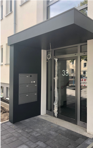
Parkstr. 33, 59425 Unna (Bauzustand)
